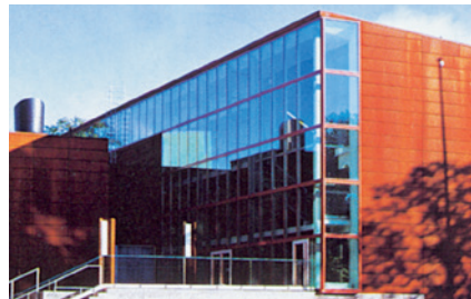
図2: 亜鉛めっき鋼板製の着色された建物外観
